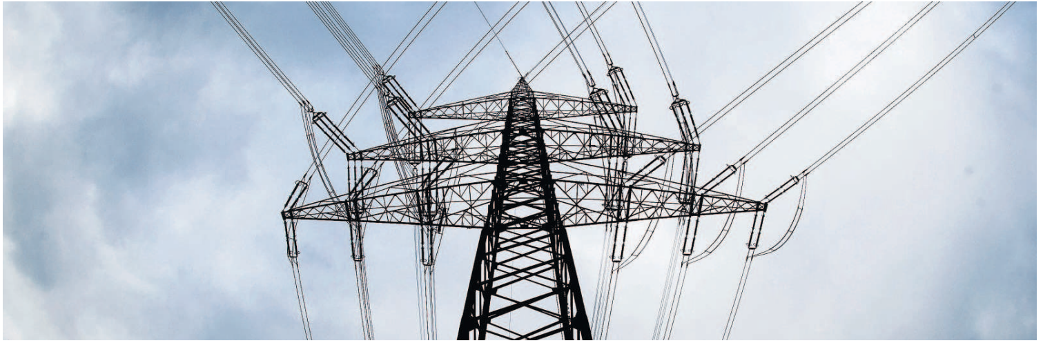
Kommt die Trasse, kommen auch die Strommasten: Ein Anblick, der nicht allen gefällt.
